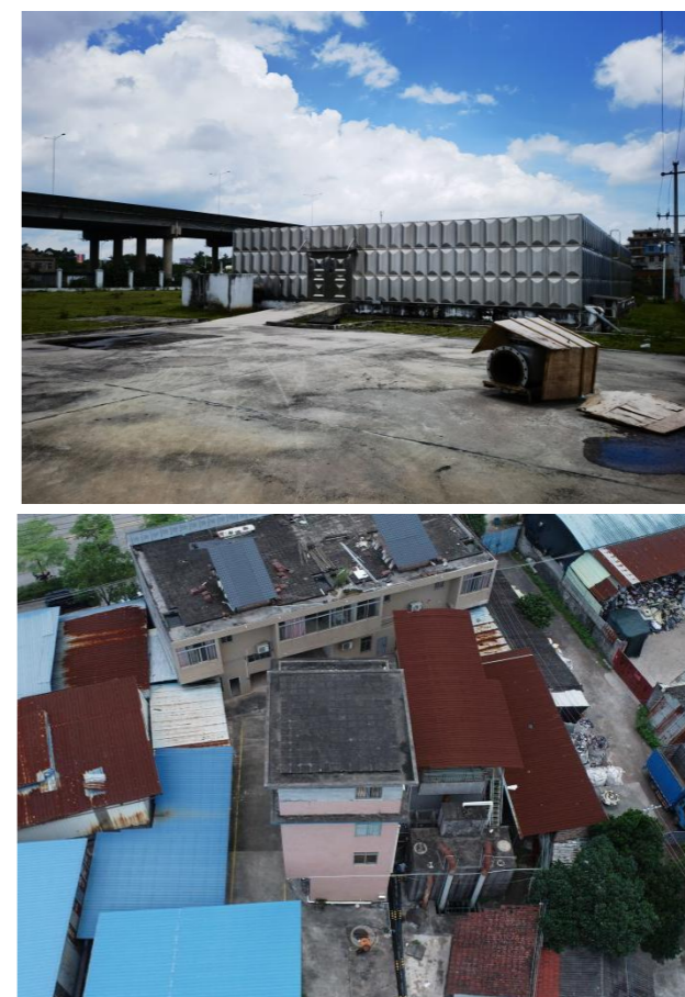
图4 城南、鸦桥供水加压站
